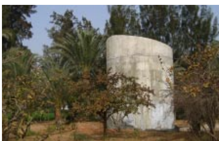
Der unverputzte Wasserbehälter vor der Fertigstellung
