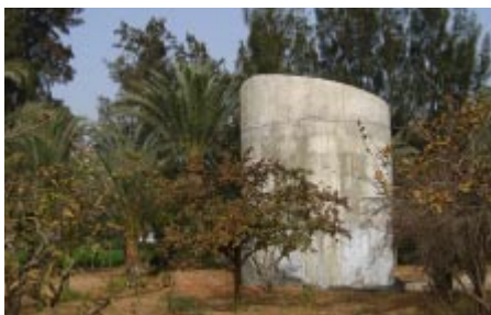
Der unverputzte Wasserbehälter vor der Fertigstellung
